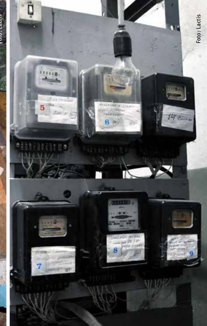
Se instalaron medidores eléctricos viejos para facilitar las mediciones individuales.
